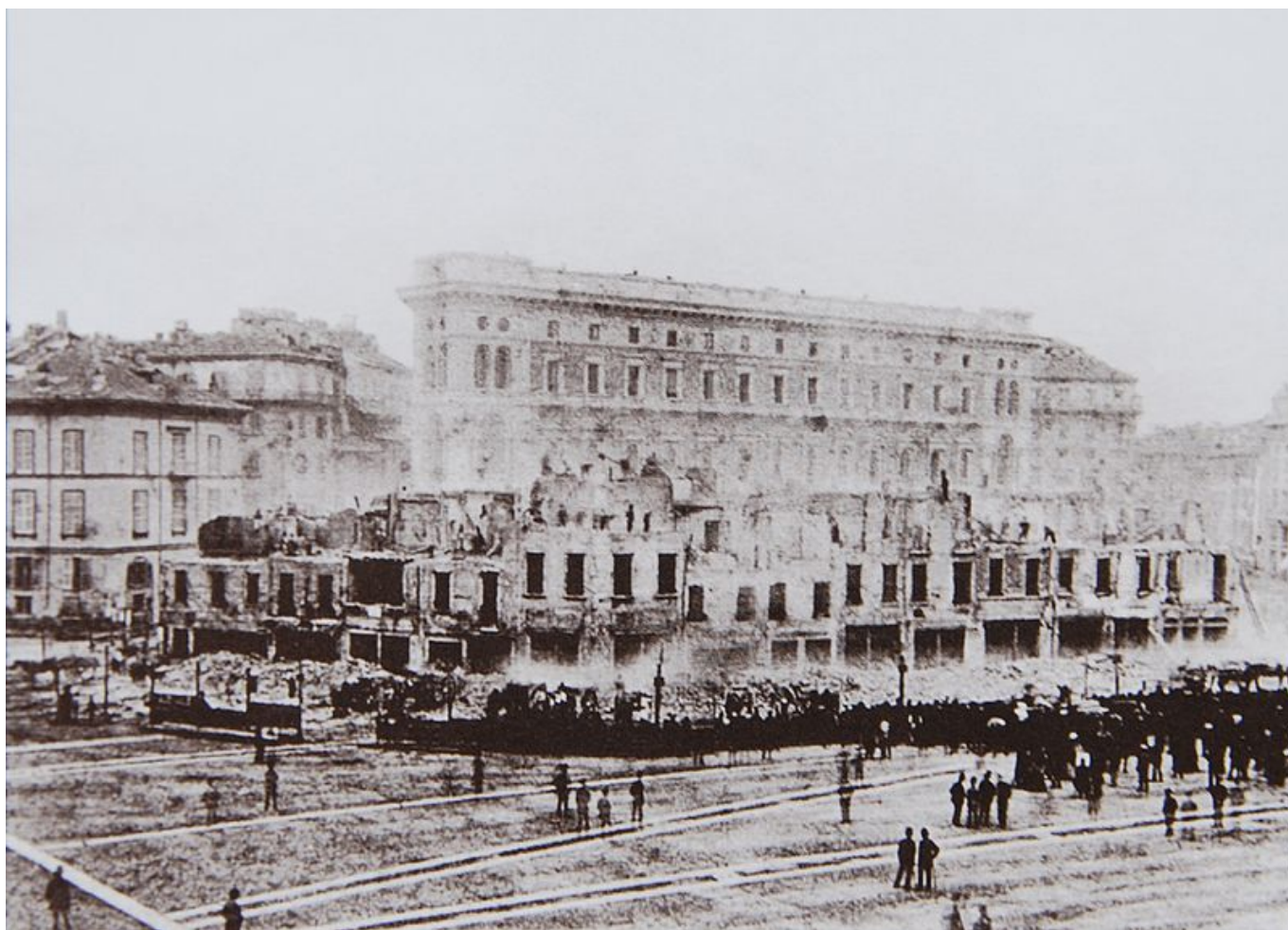
Demolizione del rione Rebecchino in una foto di anonimo, 1875.
