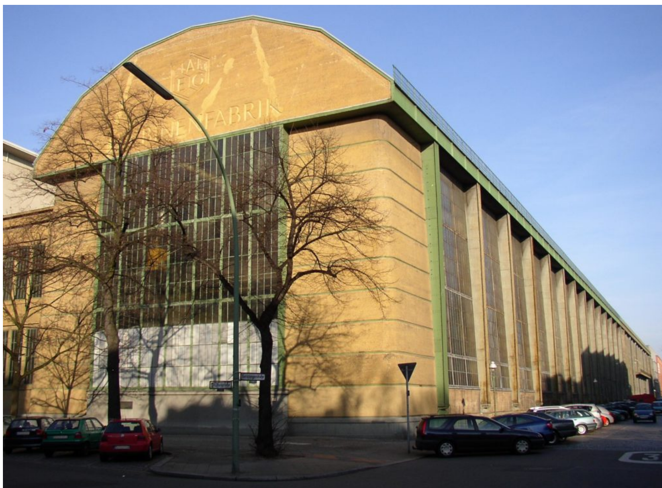
Turbinenfabrik: facciata (foto Doris Antony/Wikimedia Commons).
