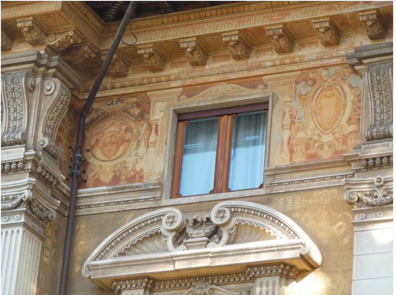
Palazzina Maria Pia di via Piaggio 31, seconda metà sec. XIX, dettaglio della facciata.
