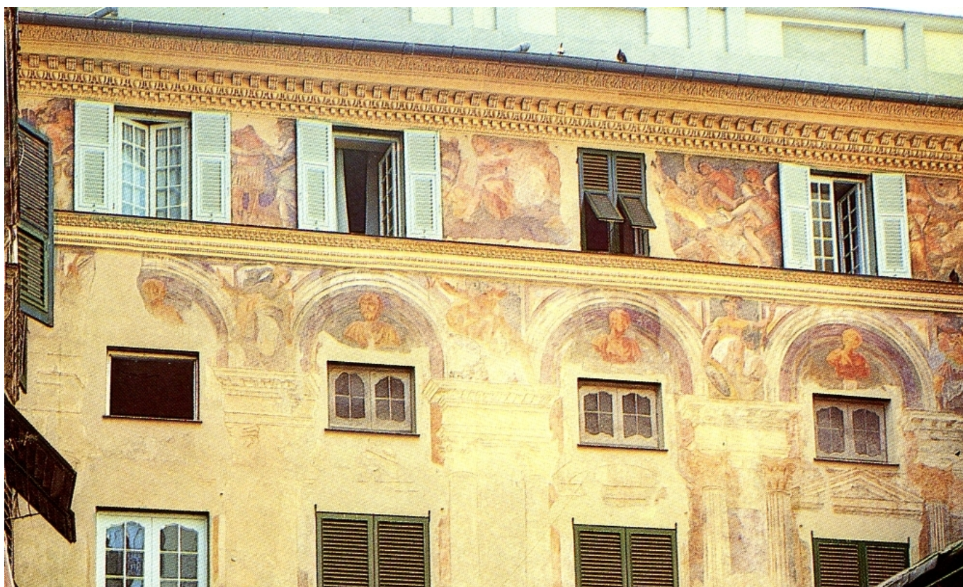
Palazzo Squarciafico, dettaglio della facciata dopo il restauro del 1982.
