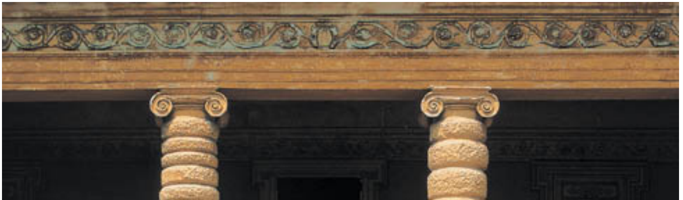
Andrea Palladio, Villa Serego (capitelli e fregio del loggiato), 1565, San Pietro in Cariano.
