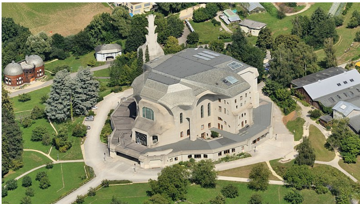
Il Goetheanum di Dornach, ricostruito nel 1922 su progetto di Rudolf Steiner dopo l'incendio che aveva distrutto la prima versione dell'edificio (Taxiarchos228/Wikimedia Commons).
